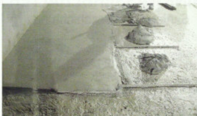
Verlegen des Estrichs.
