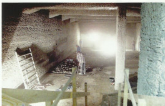
Bei der Instandsetzung der Doppelkammern wurden rund 100 Tonnen Material ausgebaut und abtransportiert.
