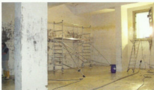
Der Estrich wies großflächige Hohlstellen auf.
