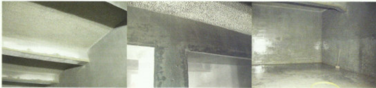
Fertig beschichtet: Decke mit Unterzügen, Wände und Boden.
