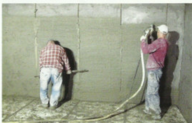
Die Beschichtung wurde in Spritztechnik aufgebracht.
